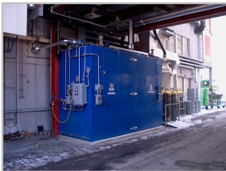
Varmeovn til 16 tromler, opdelt i 2 separate rum, hver til 8 tromler. Drives af varm olie, temperatur op til 150°C, Atex godkendt.
